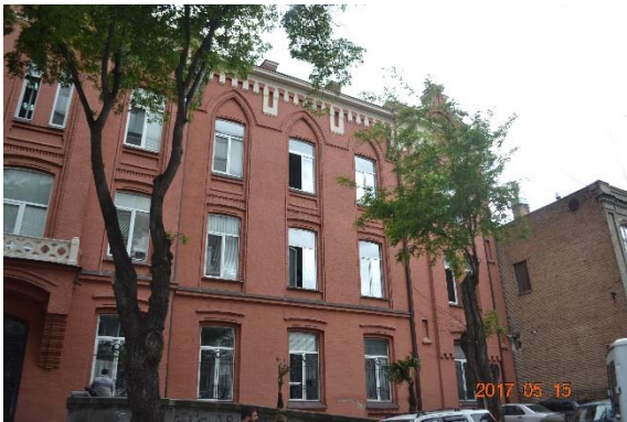
სურ. 1 საერთო ხედი
