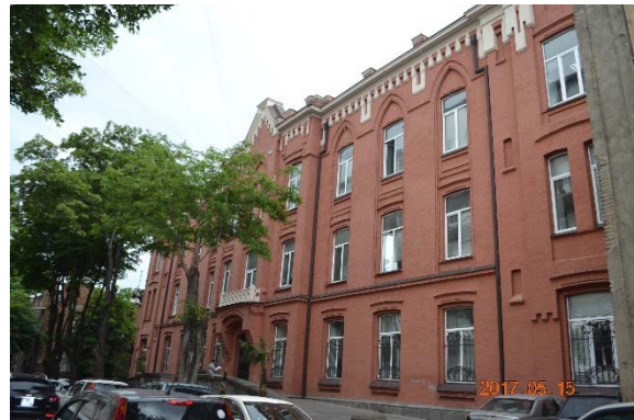
სურ. 2. საერთო ხედი
